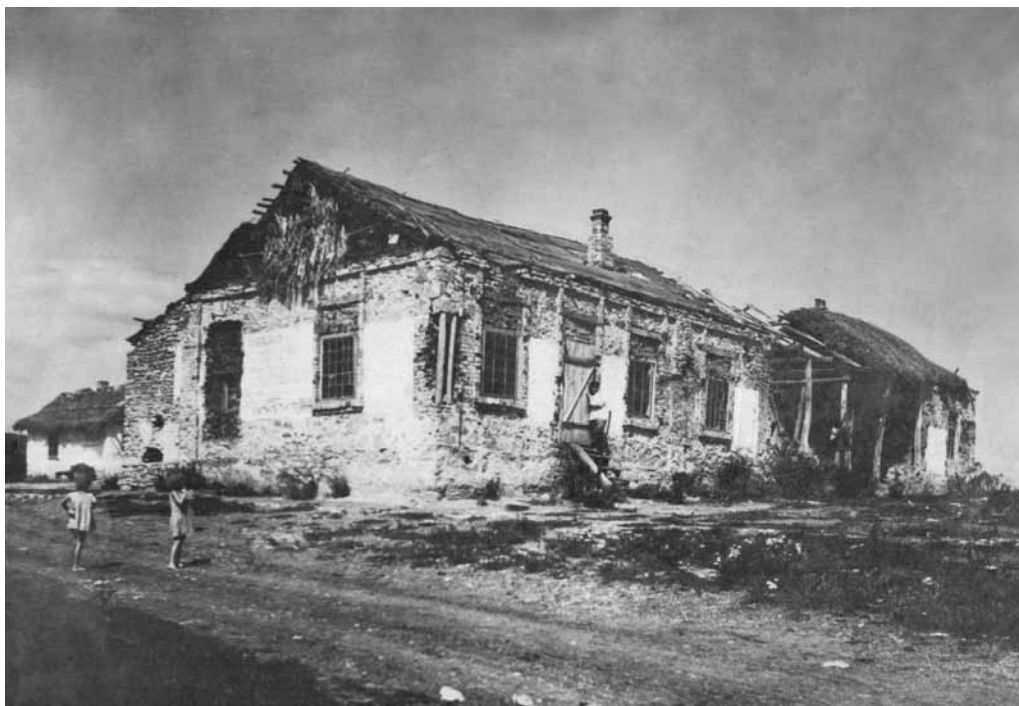
Сохранившееся здание совхоза в 1946 г.
